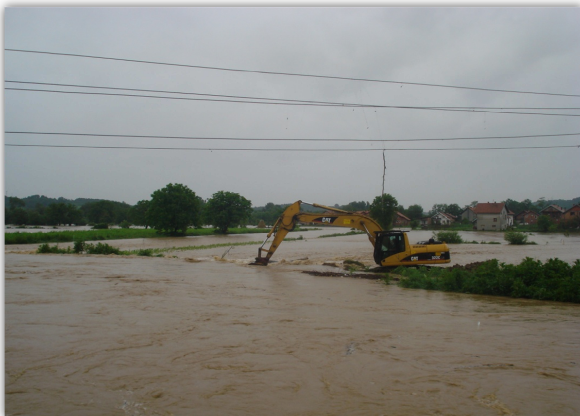
Probijanje nasipa u naselju Špionica centar kako bi se izbjeglo plavljenje stambenih objekata
