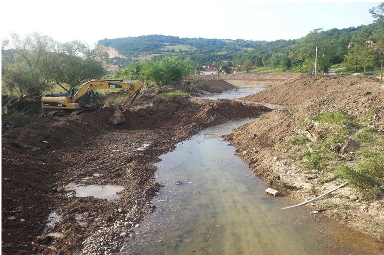
Radovi na uređenju korita rijeke Tinje
