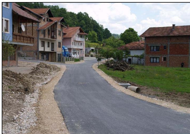
U Polju novi asfalt u dužini od 640 metara
