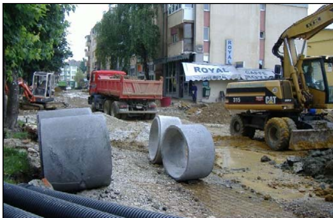
Izmjena svih instalacija u pješačkoj zoni
