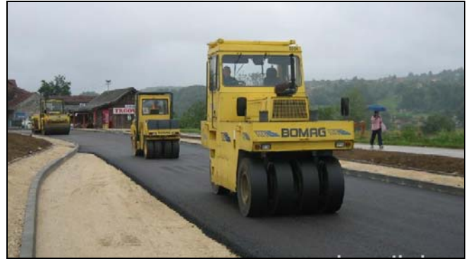
Detalj sa asfaltiranja raskrsnice
