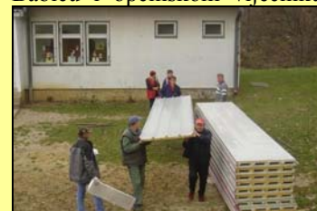
Ploče za novi krov
