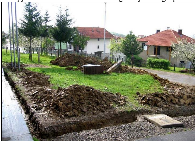
Početak radova na izgradnji spomen obilježja i spomen parka u Ljenobudu
