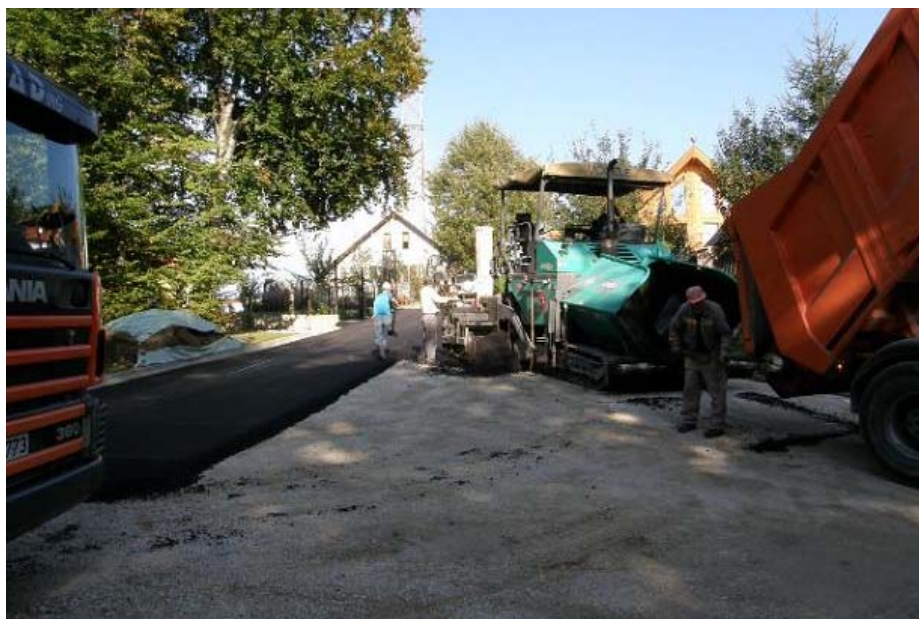
Detalj sa asfaltiranja puta
