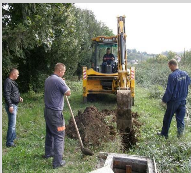
Početni radovi na izgradnji vodovoda
