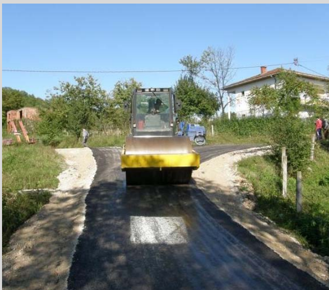
Asfaltiranje puta u Brničanima
