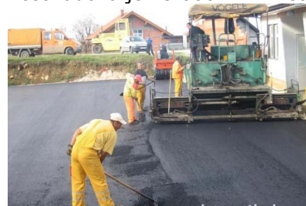
Asfaltiranje poligona
