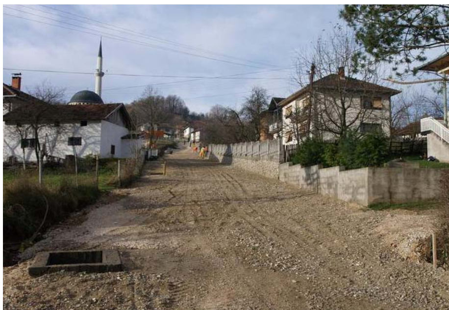
Sve je pripremljeno za asfaltiranje puta u Muratima
