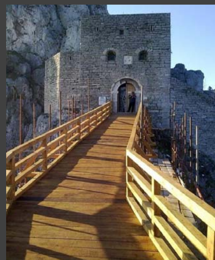
Novi most na Gradini
