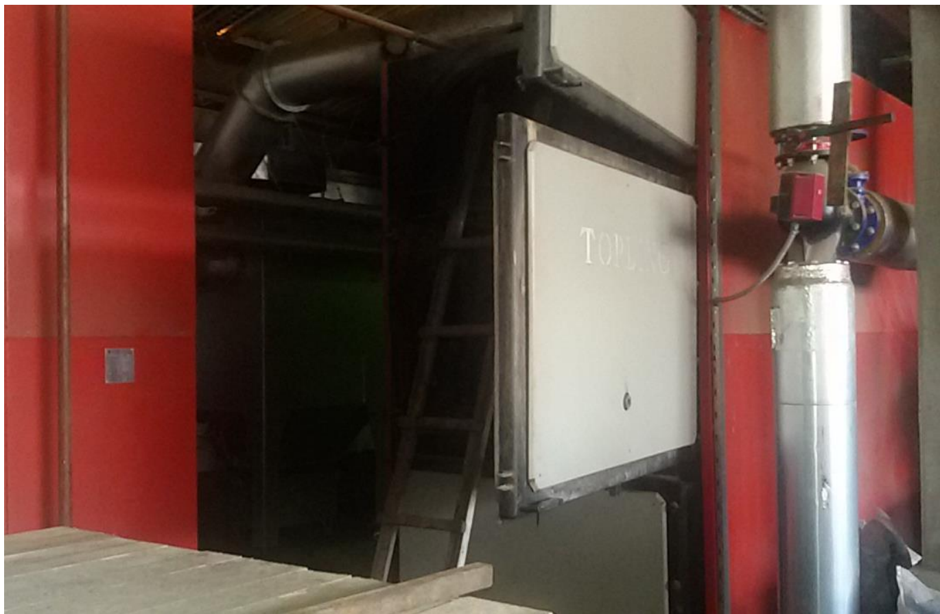
Slika 25. Kotao Topling Prnjavor sistema centralnog grijanja grada Srebrenika
