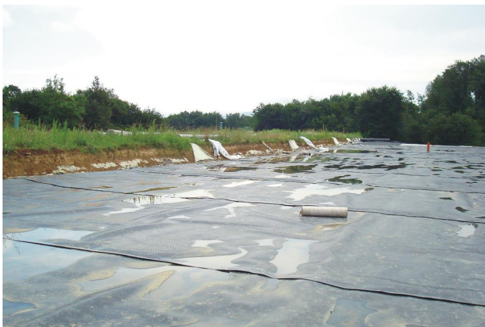
Slika 28. Ugradnja geomembrane
