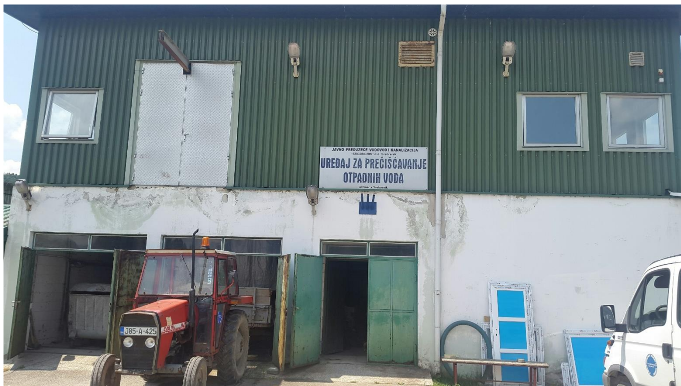
Slika 23. Uređaj za prečišćavanje otpadnih voda
